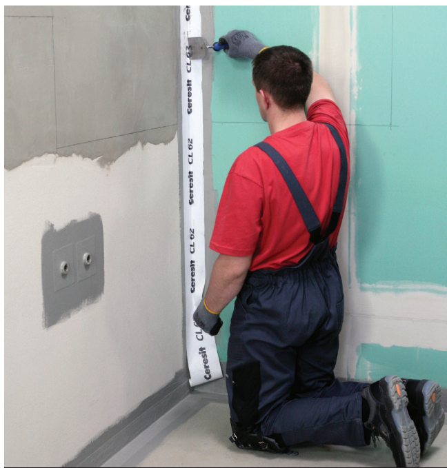
Wklejanie taśmy uszczelniającej CL 62 w narożnikach pionowych.
